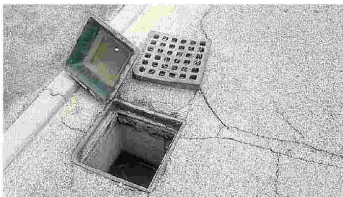
Via Lamarmora allagata. Sotto, una caditoia con portata ridotta da un diaframma in plastica
