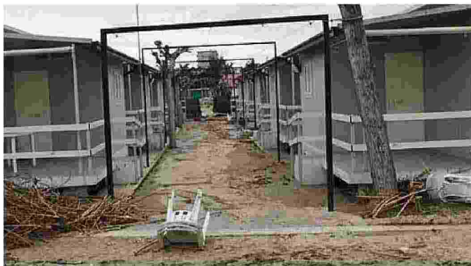
Il camping Europa completamente distrutto dall'alluvione
