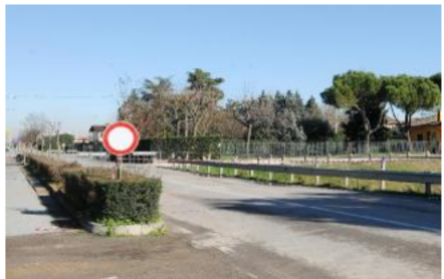
Il ponte sul canale Zerpano chiuso al traffico da due anni
