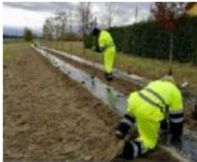
L'avvio dei lavori
