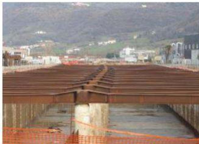
Il cantiere della galleria sul lato di Castelgomberto. A.C.
