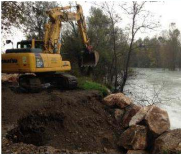
Una ruspa in un cantiere per rinforzare argini di un fiume
