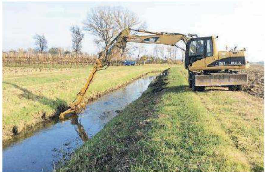
I lavori promossi dal Consorzio di bonifica Piave
