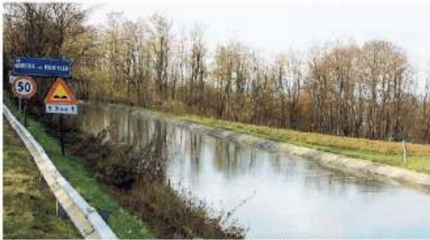
Canale di derivazione a piena portata, in questi giorni invernali, a Giavera: alimenta cascate e centraline elettriche
