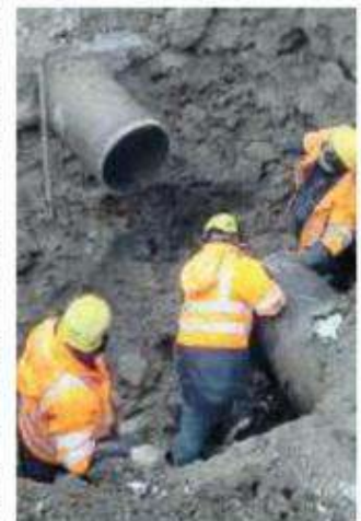
INTERVENTO Manutenzione anti allagamenti sulla rete idrica
