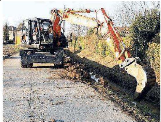
Spurgo in azione a Cavasagra di Vedelago per la realizzazione della canaletta. Sotto, lavori a San Zenone
