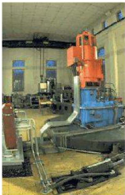
La centrale idroelettrica di Bassano
