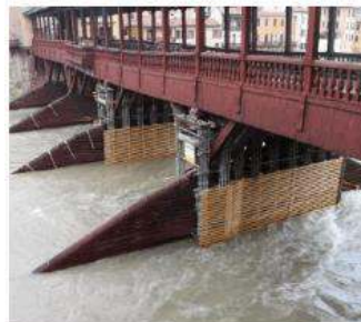
Un particolare delle stilate: ture e strada sono sommerse
