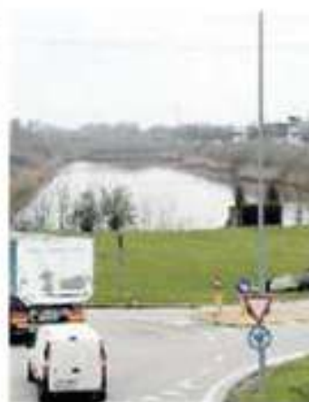
OPERA DA COMPLETARE L'idrovia in Riviera
