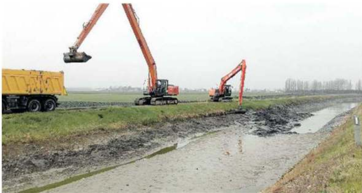
LA DECISIONE Partiranno entro la fine del mese i lavori di sistemazione idraulica lungo i fossati di via Vegri per evitare gli allagamenti
