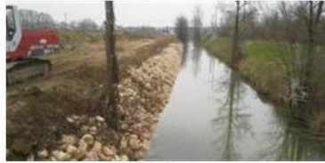
Oltre quattrocento tonnellate di pietra per lo scolo Cordano
