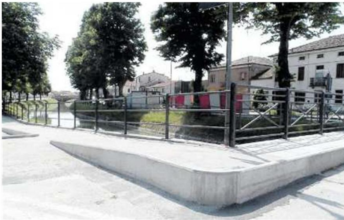
LENDINARA I lavori in corso per la sistemazione del Ponte Nuovo che poi verrà abbellito
