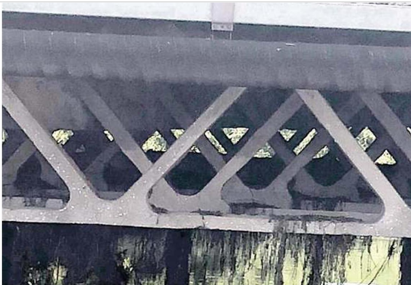
A RISCHIO Le evidenti crepe al ponte di Fratte sul canale Vandura
