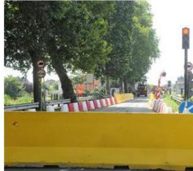
Il ponte sul fiume Tione chiuso al traffico lo scorso luglio
