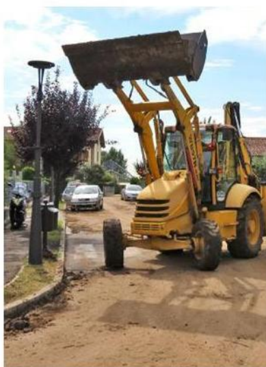
Una ruspa al lavoro per ripulire Costeggiola. FOTOGRAFATO
