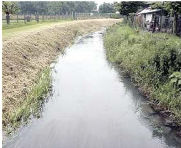
INTERVENTO ATTESO quello della messa in sicurezza del rio Vernise
