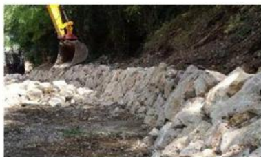
I lavori che sono stati effettuati sul torrente Igna, a Zugliano
