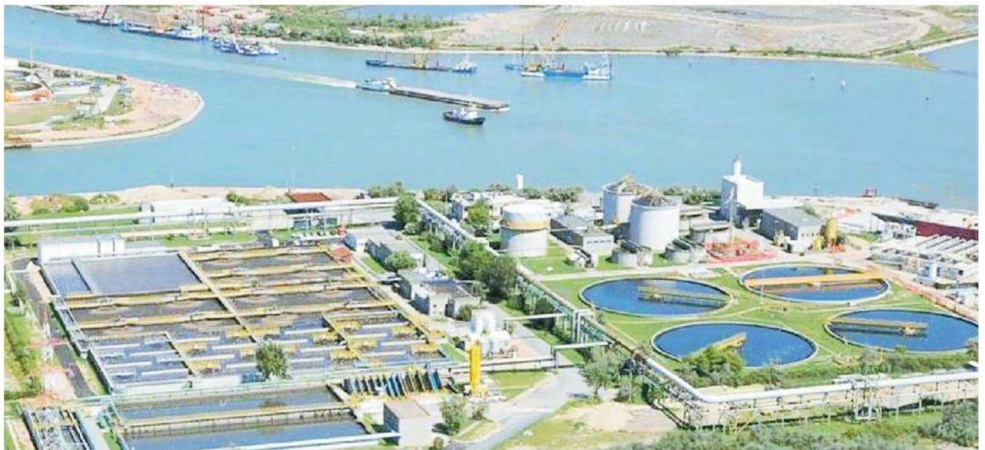
Una veduta dall'alto del megadepuratore depuratore del Pif in funzione a Fusina
