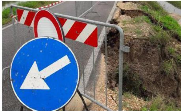
Il tratto di via Saccavezza chiuso al transito dopo il cedimento della banchina stradale
