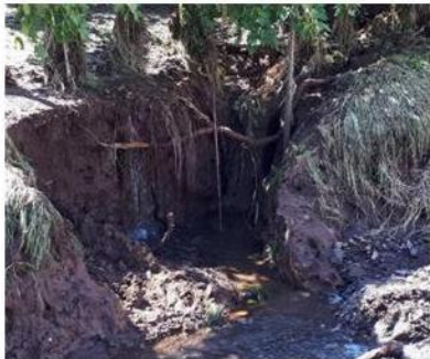
Cedimenti del Rio delle Carbonare ai primi di settembre
