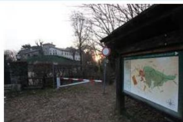
L'accesso al percorso pedonale che costeggia i lavori effettuati
