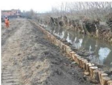
I lavori hanno previsto lo sfalcio e l'abbattimento di piante
