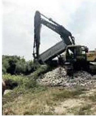
INONDAZIONE Lavori per sistemare l'argine
