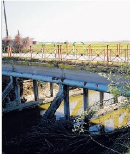
Il ponte sul Nuovo Scolo
