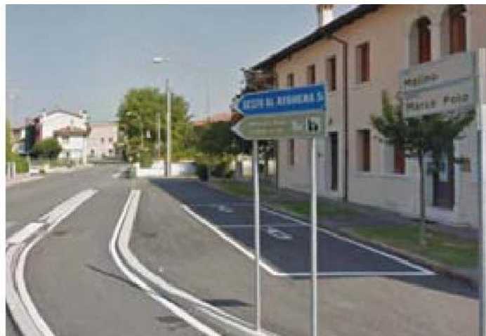
I lavori di posa della fibra ottica sono partiti da via Molino
