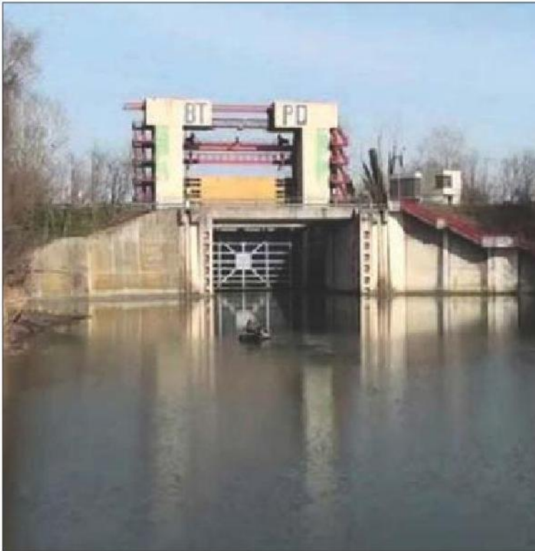
Una delle tante chiuse costruite sulla Padova-Venezia e mai utilizzate
