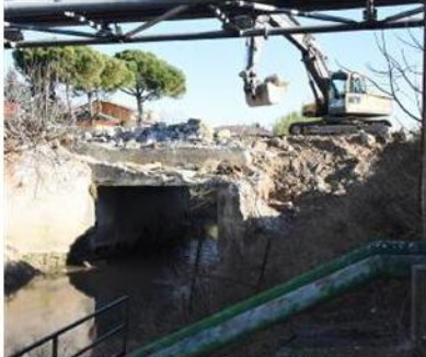
La demolizione del vecchio ponte pericolante sullo Zerpano
