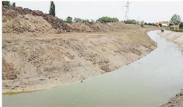
Aperto il cantiere sul canale Altipiano a Bovolenta
