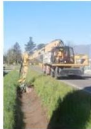
Uno dei mezzi al lavoro
