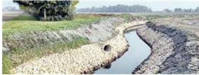
I LAVORI Un esempio di intervento del Consorzio per la sicurezza
