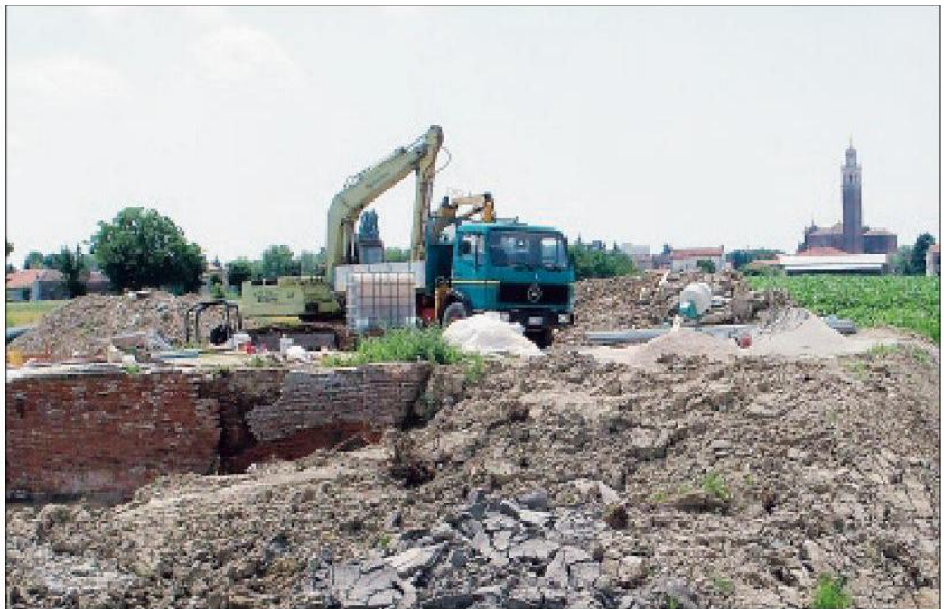
Partono i lavori di deviazione del cavo maestro del bacino superiore (foto generica di archivio)
