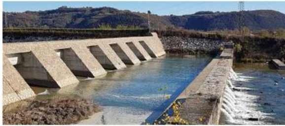
Due bacini anti-piena Procedono spediti i lavori in quello di valle come confermato dall'assessore Bottacin, a.c.
