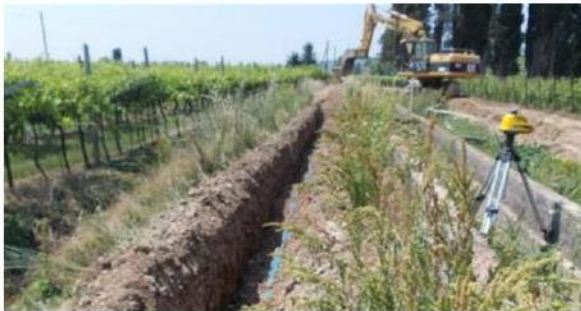
La prima parte dei lavori è già in corso, mentre la seconda sarà fatta nel 2024
