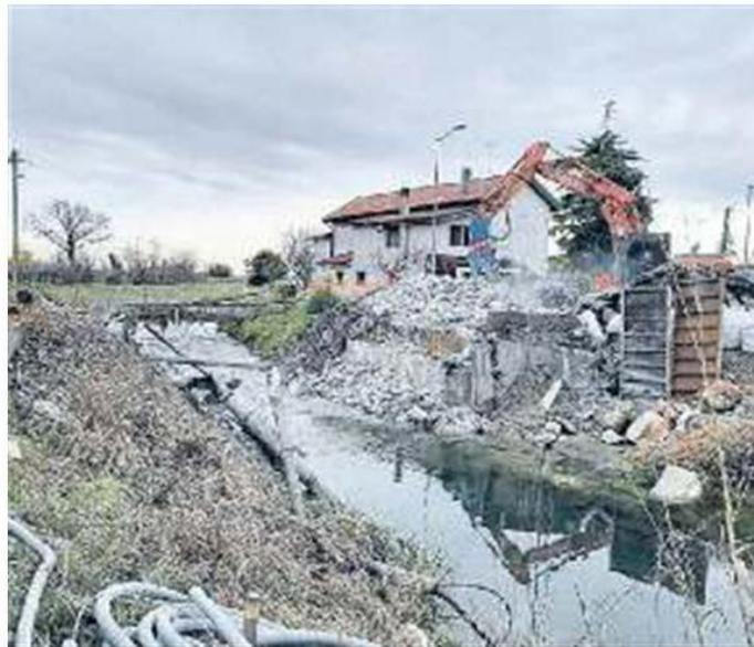
DEMOLITO Il ponte sul Ghebo sarà costruito per evitare esondazioni
