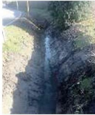
SICUREZZA IDRAULICA Decollata la pulizia degli scoli
