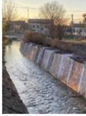
Il Volon I lavori in via Cavour
