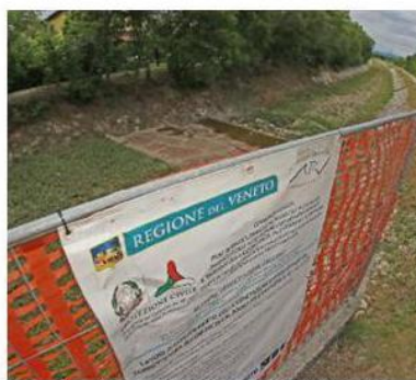
Le opere i lavori del consorzio lungo l'Igna a Novoledo di Villaverla (1). A. S. T. I. A.
