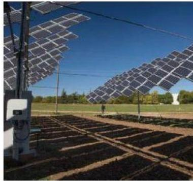
Un sistema agrivoltaico per la produzione di energia sui campi coltivati
