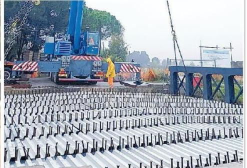
L'operazione di posa dell'impalcato del nuovo ponte sul canale Altipiano con cui si accede all'idrovora storica a Santa Margherita di Codevigo
