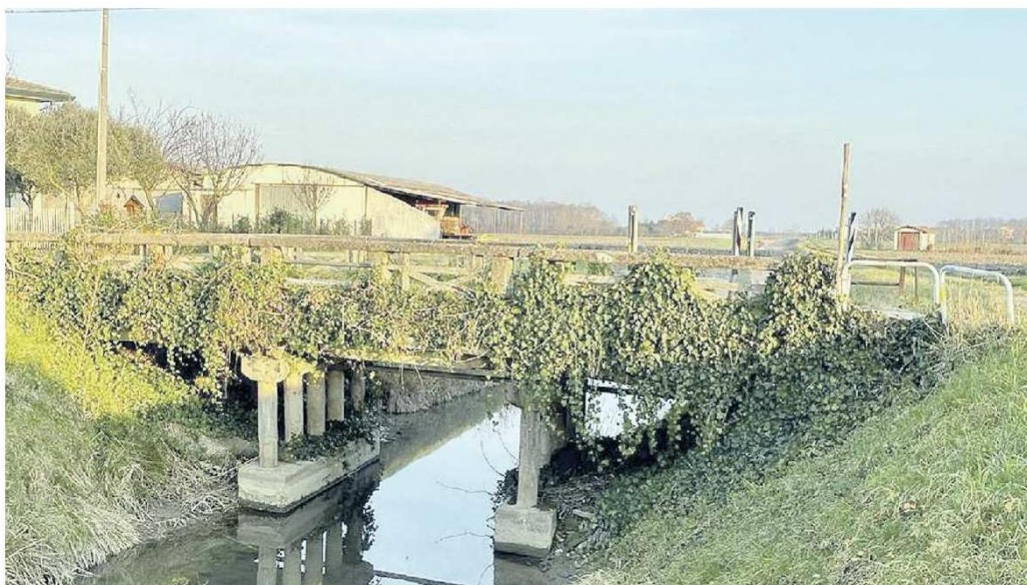
VERIFICHE Il ponte della Pietra a Fossà e, sotto, il ponte di via Pio X a Passarella di San Donà
