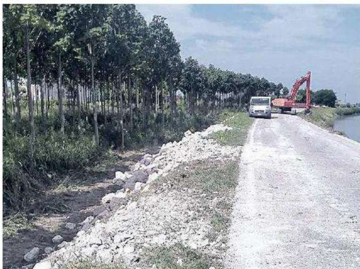
VIA ARGINONE Ripristinata la sede stradale dopo la frana che aveva interessato il Collettore padano e riapertura alla viabilità
