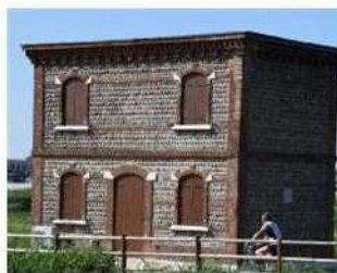
Presenza storica La Casa Bombardà
