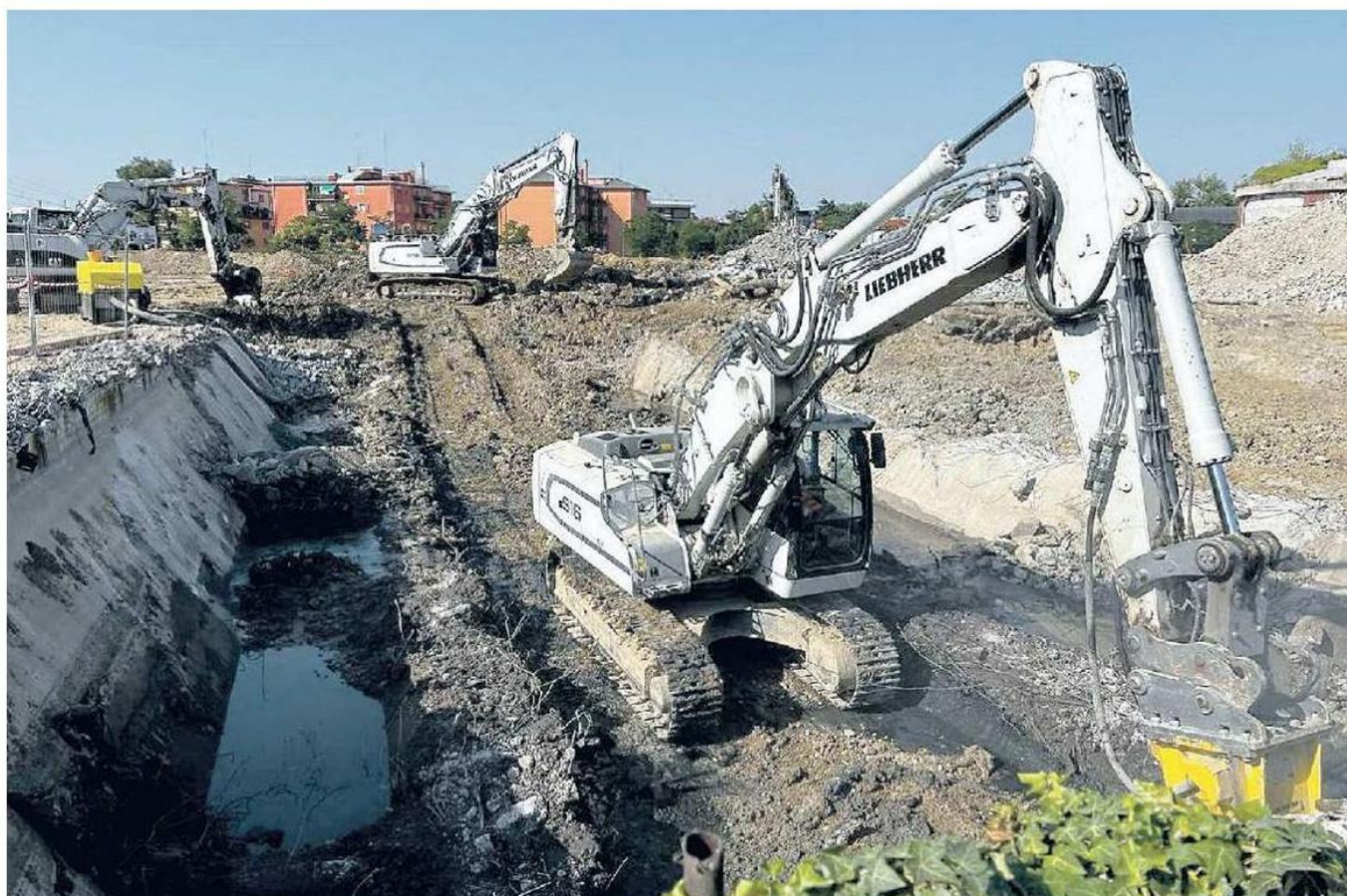
VASCA DI ACCUMULO I lavori per la realizzazione della nuova vasca per il trattamento delle acque in via Bissagola
