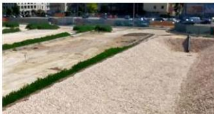
Lavori anti allagamenti Un bacino di laminazione in via Rovere
