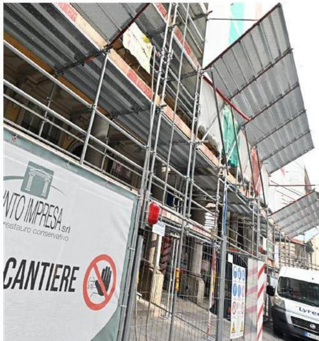
Un cantiere dedicato al Superbonus ci sono ancora molti edifici rimasti "incagliati" nell'iter
