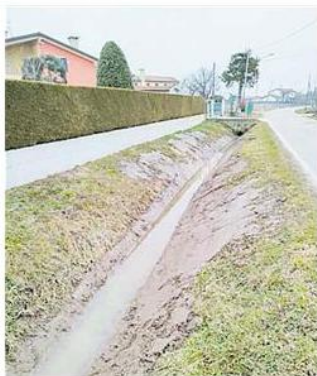
Lavori per la sicurezza idraulica
