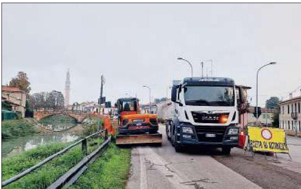
Via libera ai lavori di ampliamento e completamento della ciclabile Adige-Po
