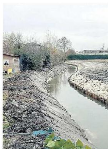
CANALI DI SCOLO I lavori sulle rive
