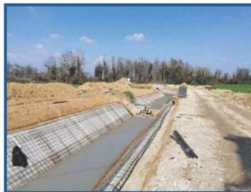
Canale Maestro getto fondo canale dopo i lavori
