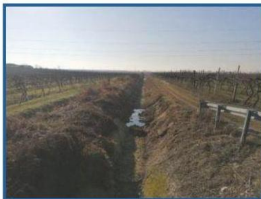
Canale Maestro da Via Gombion verso monte prima dei lavori
