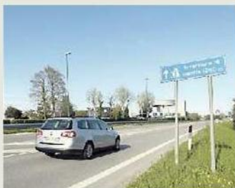
LAVORI IN CORSO La statale Triestina a Ca' Noghera
