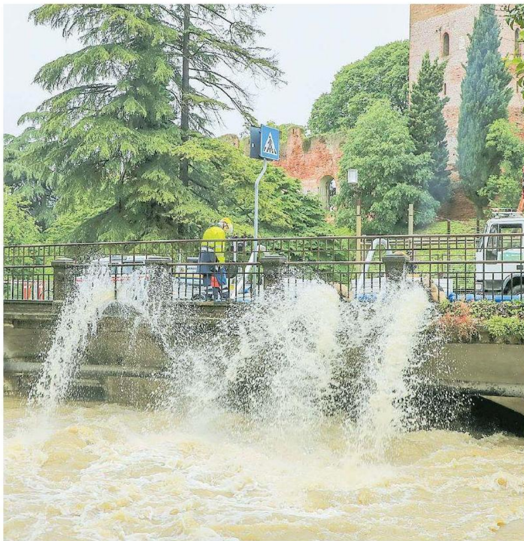
Le idrovore in azione in centro a Castelfranco sul fossato delle mura
