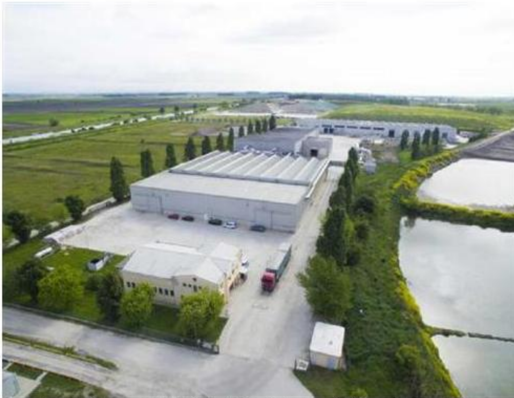
Discarica Una visione aerea dell'impianto di Torretta che serve 98 Comuni della provincia
