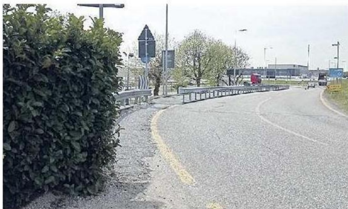
LAVORI Il tratto di strada su cui sarà realizzata la pista ciclabile
