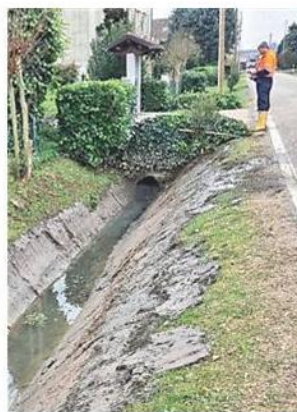
Sopralluogo in un fosso
