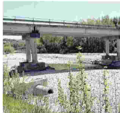
Ponte sul fiume Metauro a Cerbara
