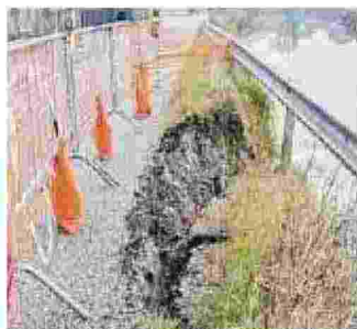
La frana a Coccanile
