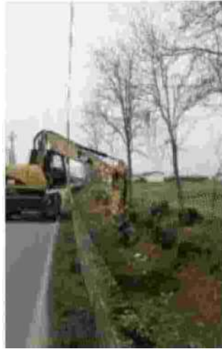
I lavori in via Baroni
