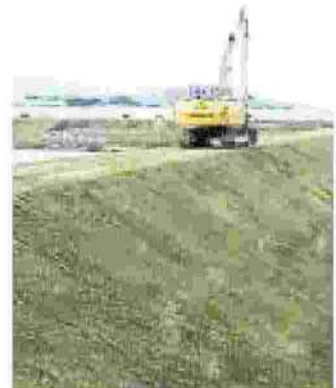
I lavori sul torrente Ombrone
