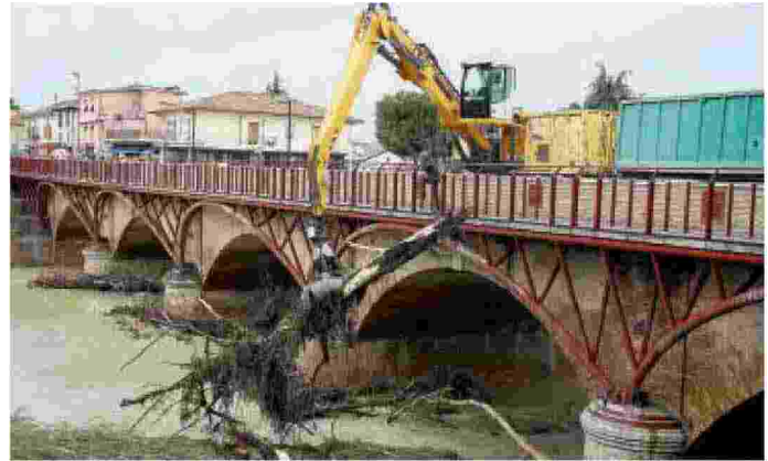
L'intervento dei giorni della piena del Savio
