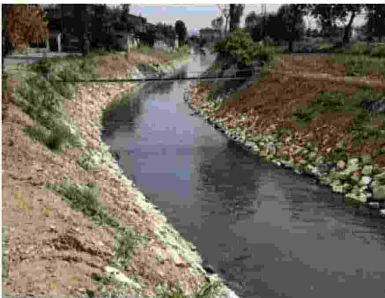
I lavori di sistemazione delle sponde in uno dei corsi d'acqua oggetto del piano di lavori. CAROLLO
