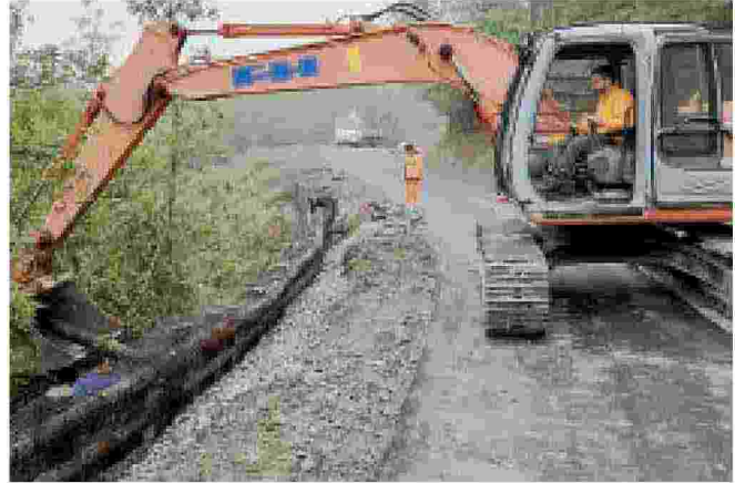
INTERVENTO Gli operatori della Bonifica al lavoro.
