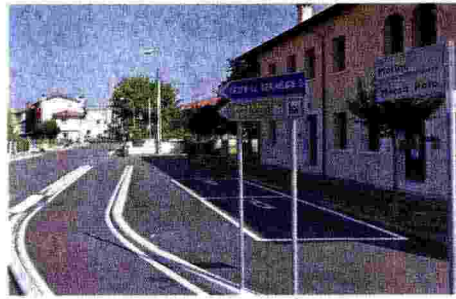
I lavori di posa della fibra ottica sono partiti da via Molino
