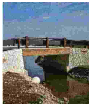
Il nuovo ponte di via Boeca. A.I.
