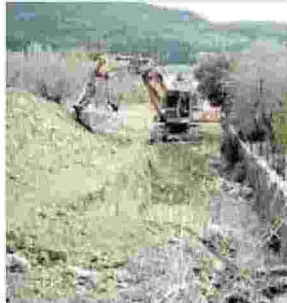
Lavori nella zona di Ascoli
