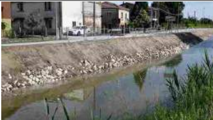
Il tratto di strada oggetto dei lavori di consolidamento
